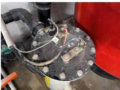
Por otro lado, hay una célula de producción cuyos bornes de conexiones no están protegidos. **Se hace necesario instalar su correspondiente protección para evitar daños a personas o equipos.**
