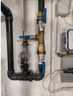
Algunas válvulas de retención de los llenados están instaladas en sentido inverso. **Solicitamos que las válvulas de retención sean instaladas correctamente.**
