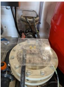
El sistema de cloración salina instalado es un buen equipo de uso profesional; pero tiene una limitación en su configuración/instalación: consta de dos células que deben funcionar simultáneamente. Cada bomba envía agua a un único filtro, lo que obliga a que ambas bombas trabajen al mismo tiempo para que el sistema pueda funcionar y mantener la cloración del agua. Esto no es óptimo, especialmente en épocas de baja demanda de filtración.
